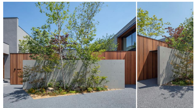
LIXILメンバーズコンテスト2022準グランプリ受賞作「layer」 外壁はコンクリートと木材を組み合わせることで圧迫感を軽減しながら、自転車を置くスペースなども確保し、生活感を上手に隠している
